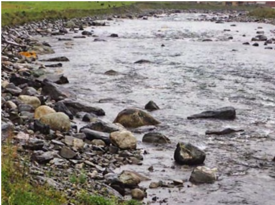
Figur 10. Eksempel på hvordan ru erosjonssikring kan gi et naturlig preg på elvekant. Kilde: Pulg m.fl.2023.
